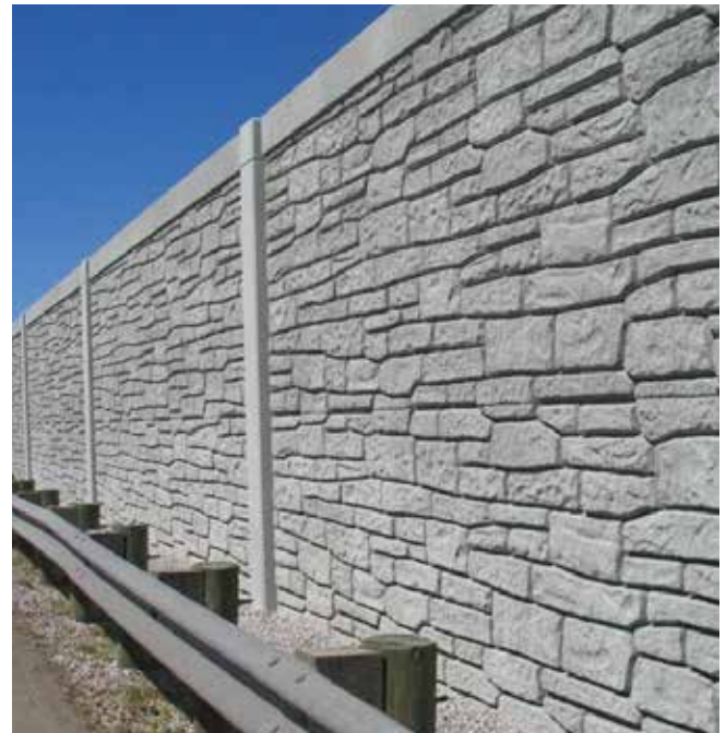
NB24 Drystack Pattern OHIO, USA
